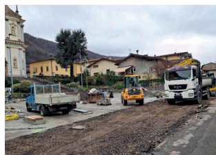
Artogne: Il cantiere di Piazza Caduti del lavoro.
