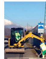
SS 42: Lavori in corso.
